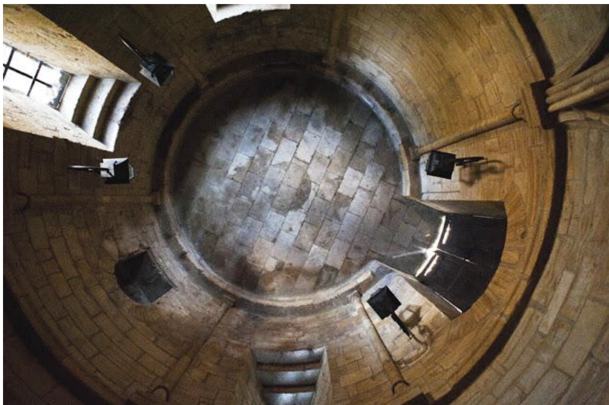
La salle du rez-de-chaussée vue du niveau supérieur par l'orifice ouvert dans la voûte. Photo Beauvert.over-blog
